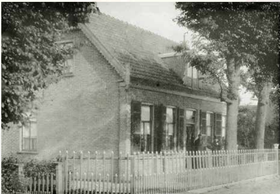
Pastoor van der Plaatstraat 23, Rijpwetering, voor 1928. Destijds bewoond door mevrouw Kuipers, die het pand van haar vader had geërfd. Het is onbekend wie de personen voor het huis zijn.
